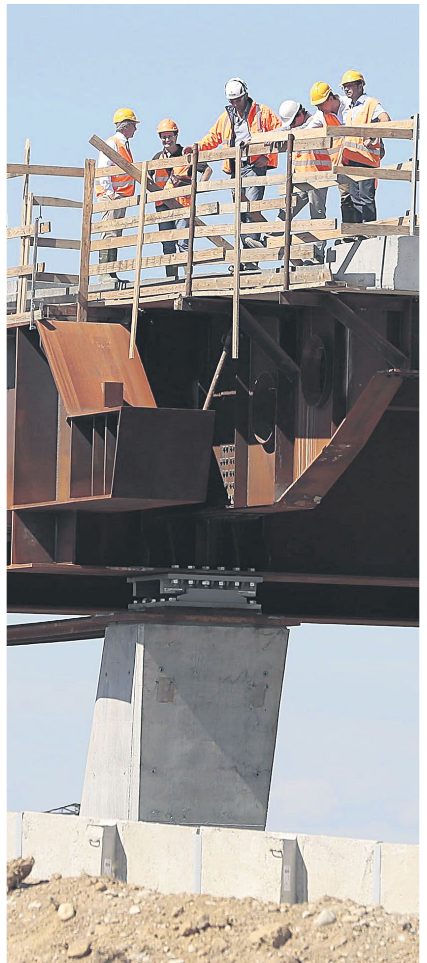
Uno dei cantieri Milano Expo 2015 FOTO LAPRESSE
