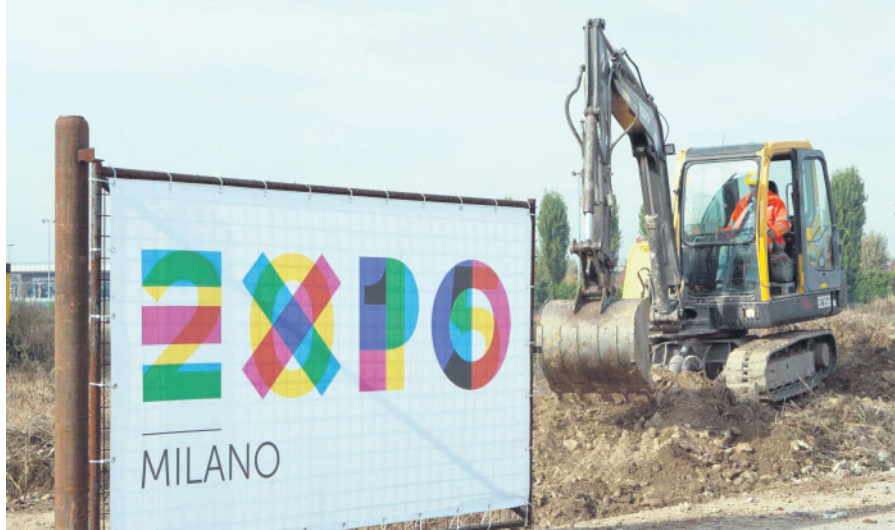
un cantiere dell'Expo di Milano FOTO INFOFOTO
