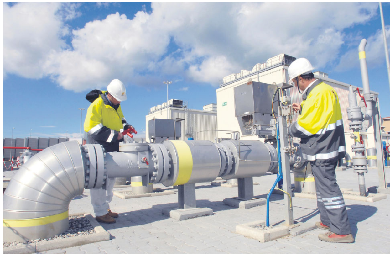
Tecnici al lavoro in un impianto Snam
